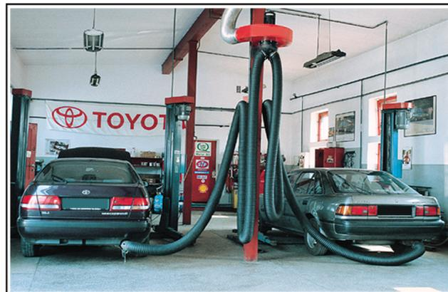
Cet équipement est constitué d'un support mural, d'un ventilateur et d'une prise d'aspiration simple ou double prolongée par des conduits flexibles.
